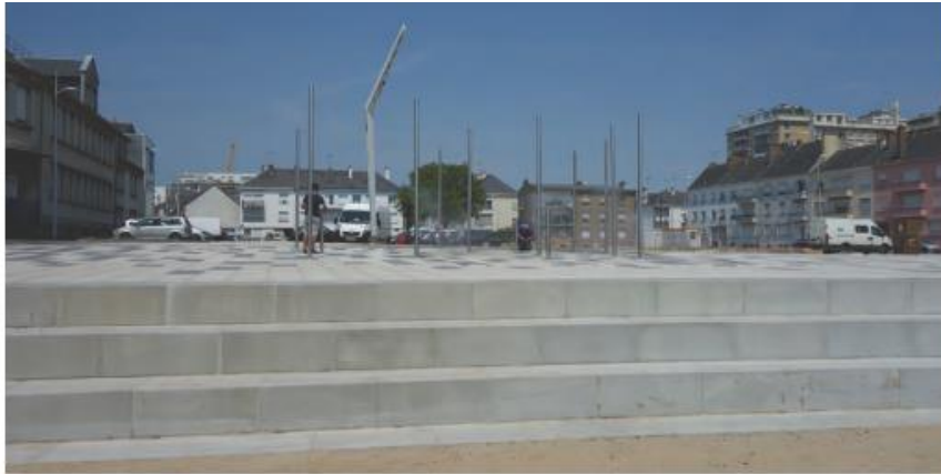
Principe de gradines en blocs béton préfabriqués. Saint-Nazaire - Phytolab
