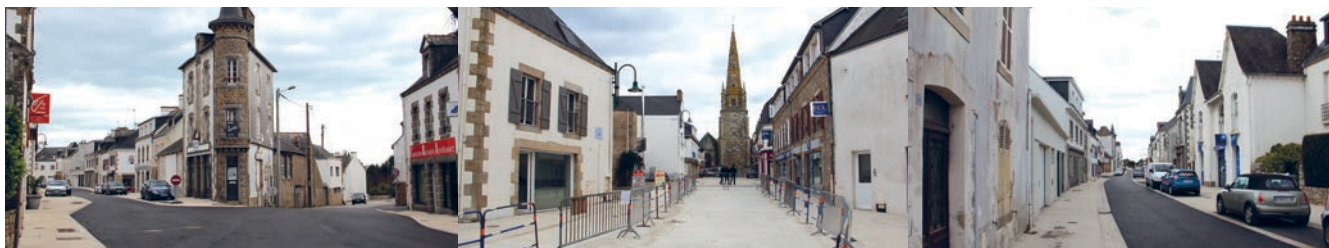
La rue St-Cornély APRÈS les travaux d'aménagement
