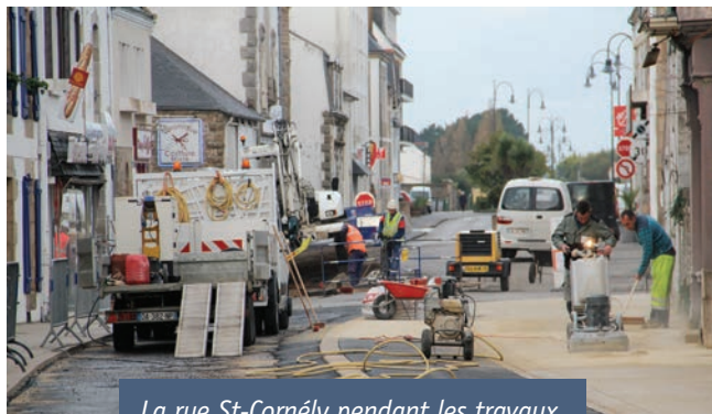
La rue St-Cornély pendant les travaux.
