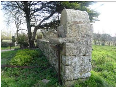
*Mur de l'enclos de la ferme de Kerdrain. Le piédroit inclut une dalle percée dans laquelle pivotent le portail.*
