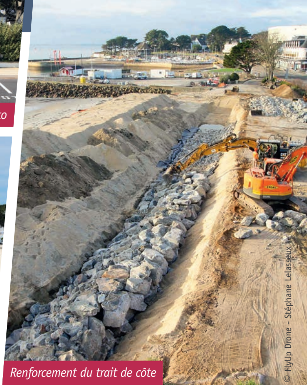
Travaux de voirie
