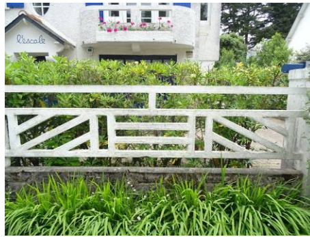
Mur bahut en pierre et claire-voie en béton armé. Villa L'Escale, vers 1930. Architecte Davesne et Roslin. J. Morel.
