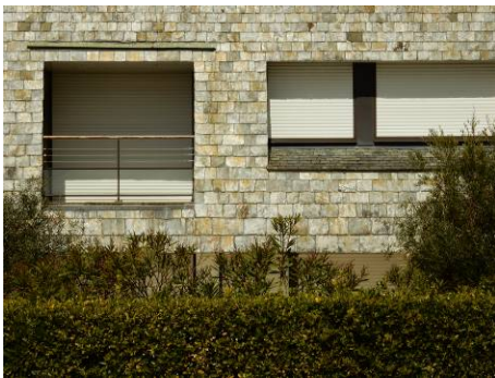
19, boulevard de la Plage. Gilhouet, architecte. Vers 1970 ? Bardage d'ardoise de schiste.
