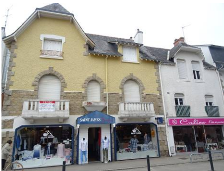
Villas aux 5 et 7, avenue Miln. A. Daveau, architecte.
