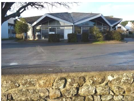
Cantine municipale de l'école Les Korrigans. Yves Guillou.
