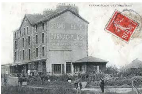
Le Grand Hôtel, inauguré en 1903. Il fut le premier hôtel de la plage. Constructeurs : les frères Jamet.
