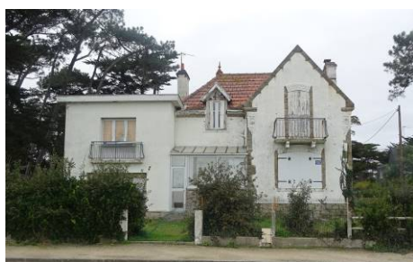
Villa Keller, 1904. 18, boulevard de la Plage. La villa a été complétée vers 1960 d'une aile latérale. Frères Jamet.
