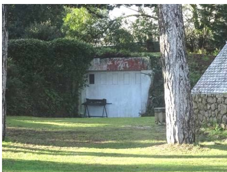
1, boulevard de Légenèse. Blockhaus transformé en garage.
