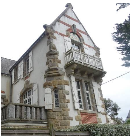
Villa Ker Margaët, Allée des Menhir. 1905-1910 ? Frères Jamet. La chaîne d'angle est traitée en blocs de granite aux tons alternés.
