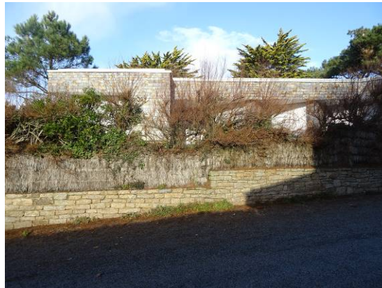
Maison Plasseraud, 28, avenue de la Pointe, 1968, Yves Guillou.
