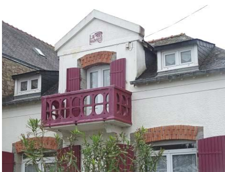
Villa La Pauvrette. Balcon en béton armé moulé. Ajout des années 1930 ?
