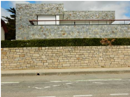
26, boulevard de la Plage, 1978 ? Yves Guillou, architecte. Bardage d'ardoises de schiste, mur de clôture en granite.
