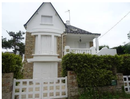
Villa de plan en faux L et d'éléments Arts déco (bow-window). Allée de Bosséno.
