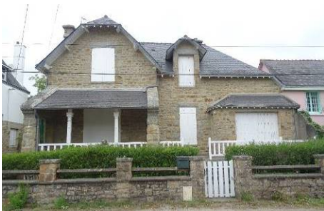
Villa Les Troènes, 55 avenue de Kermario. 1907. Frères Jamet. Bureau de la Société Anonyme de Carnac-Plage.
