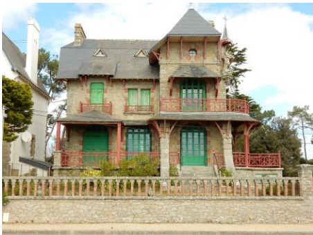
Villa Saint-Michel, 65, boulevard de la Plage, 1914. Joseph Caubert de Cléry, architecte.
