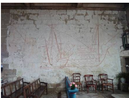
Intérieur de la chapelle Saint-Colomban. Cl. V. Rousset, 2016.
