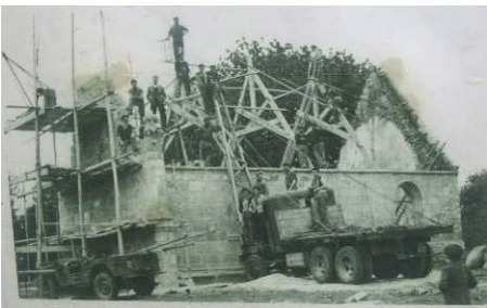
La chapelle de Kergroix en cours de reconstruction au milieu du 20 e siècle. Coll. privée.
