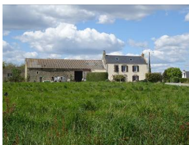
Maison à travées et dépendances, p. 69
