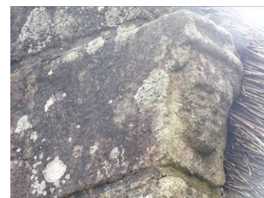
Maison à un niveau, p. 1787. Détail du corbeau de la chevronnière.
