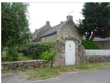
Vestiges d'une porte et maison p. 320, 321.
