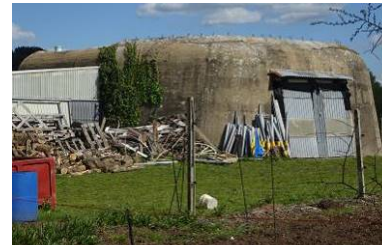
Entrepôt de munitions allemand, p. 92.
