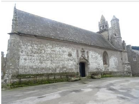
La chapelle Saint-Colomban, vu du nord.
