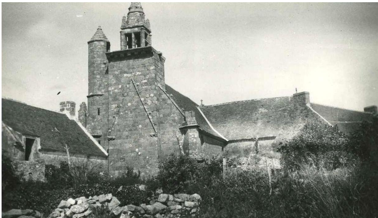
Fiche Mérimée, Chapelle Saint-Colomban : Ensemble sud-ouest, vue générale
