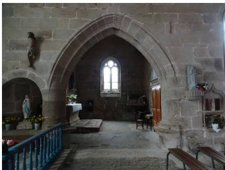
La chapelle latérale vue depuis la nef
