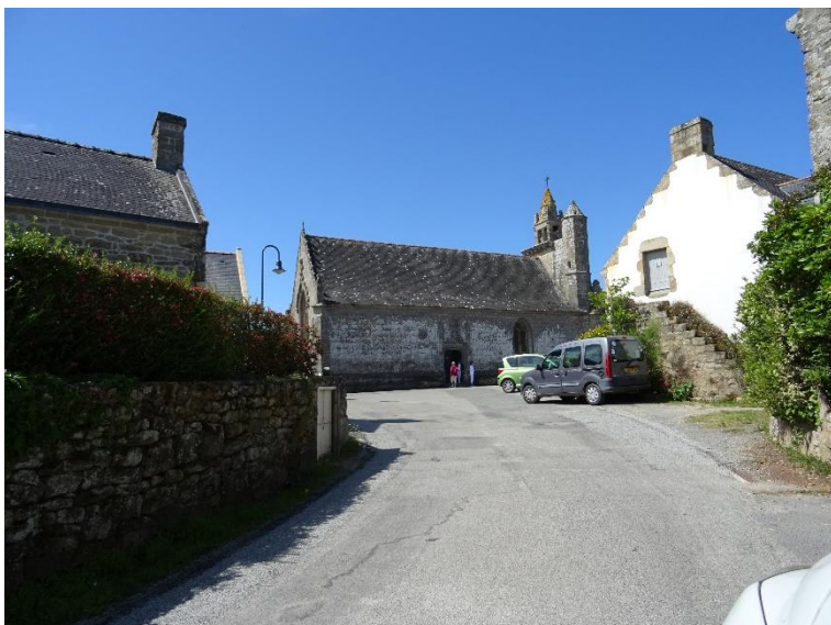
2 - Entrée de village par le nord
