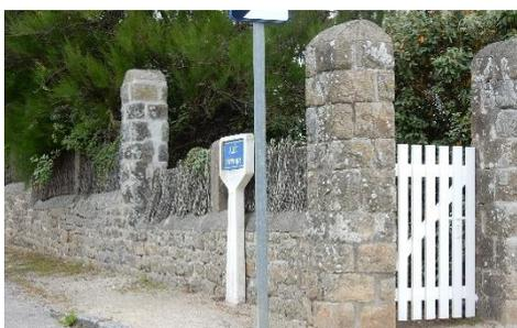
Autre clôture « modèle » de Carnac-Plage : Version mur-bahut : mur bas, pilastres et claire-voie
