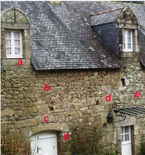
L'examen des maçonneries permet de distinguer les phases de construction, à la manière dont sont assemblés les matériaux.
