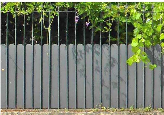
*Dans le cas de grilles, insertion d'une semi occultation par festonnage.*
