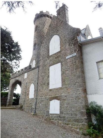
Maison Churchill. Des édifices sont conçus en pierre dont le parement est fait pour rester apparent : le haut pignon dépasse la hauteur de la couverture d'ardoise par une « chevronnière » en rampant, de même pente que la toiture.
