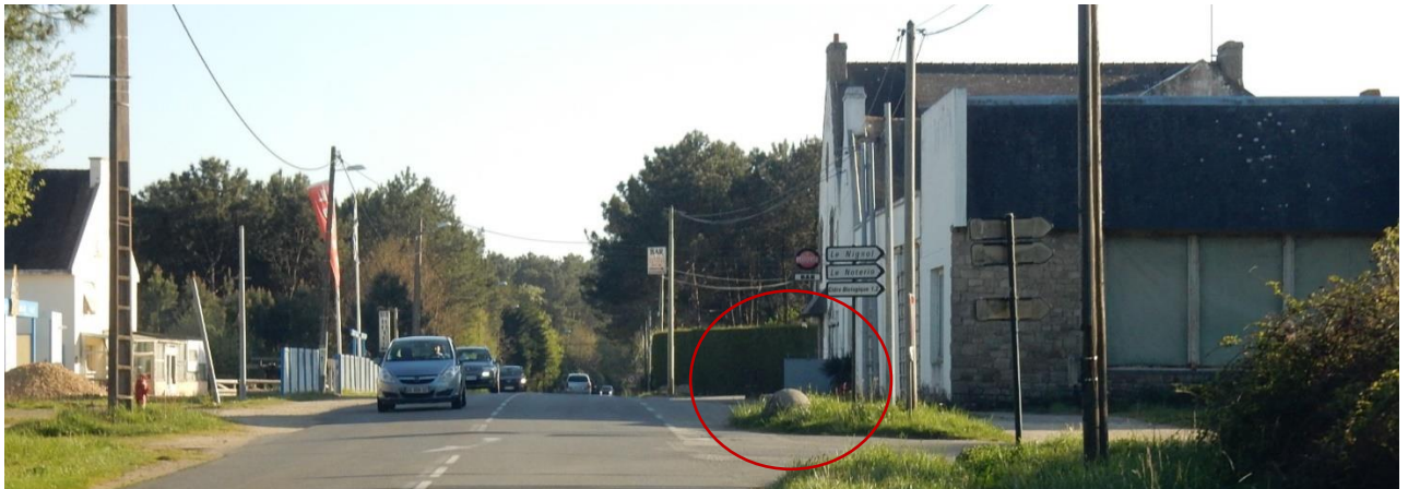
Source : BW2017, vue depuis la RD119 direction Carnac
