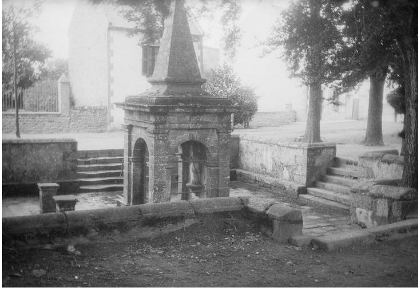
Source : fiche Mérimée, vue d'ensemble côté nord,
